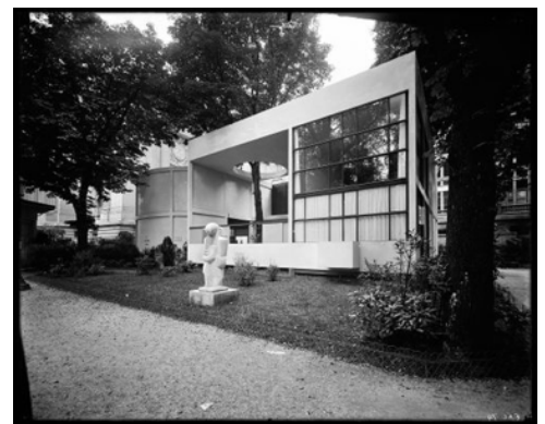
Pavillon de l'Esprit Nouveau, Le Corbusier (1928)
