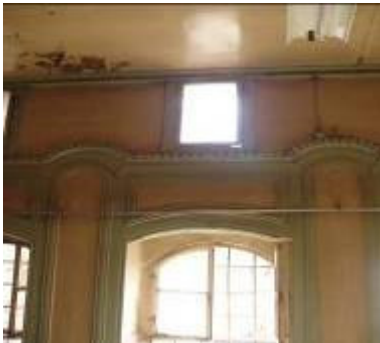
Figure 17: Window and top window (kuş tagası) of M9
