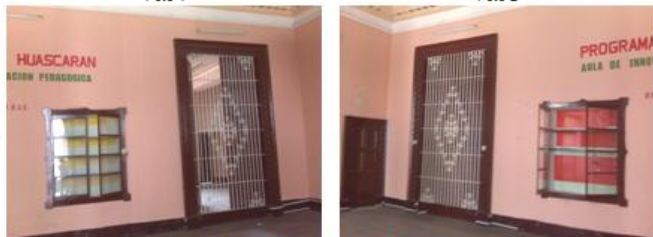
Ventanas con rejas hacia el Auditorio.
